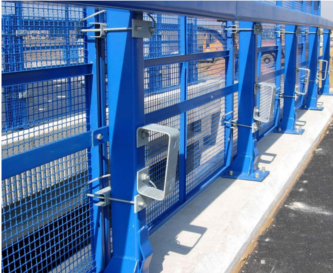
Obrázok 11 - Zvodidlo CAR H3 COMBI - foto
