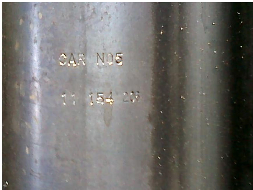
Obrázok 31 – Príklad značenia komponentov zvodidiel CAR
